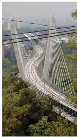
Viaducto Atirantado Manantial Santa Fe.
